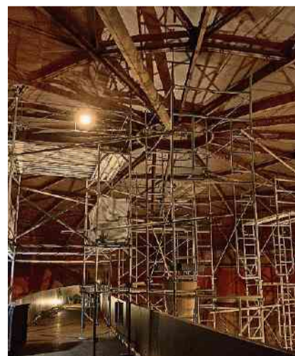
Gasometer ist bestückt mit Gerüsten.
